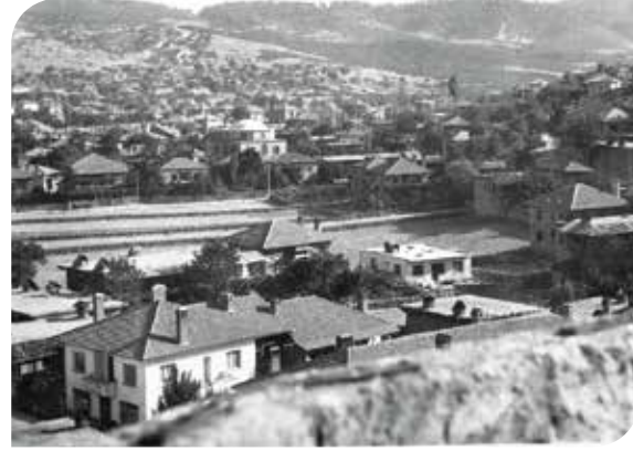
Eski Bucak'tan Görünüm- View from old Bucak
